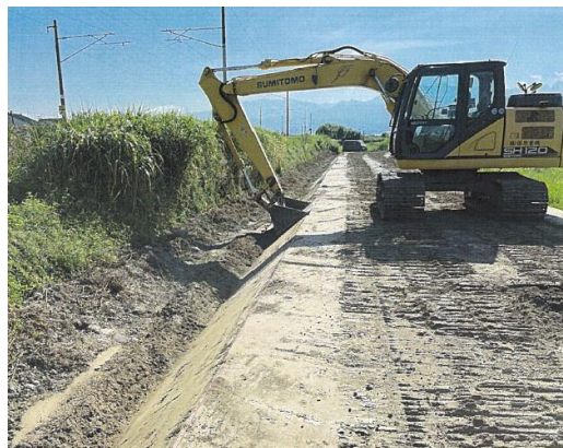
ほ場整備水橋三郷北地区第13区ほ場整備工事
