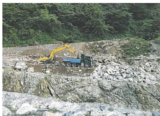
天鳥下流砂防堰堤工事
