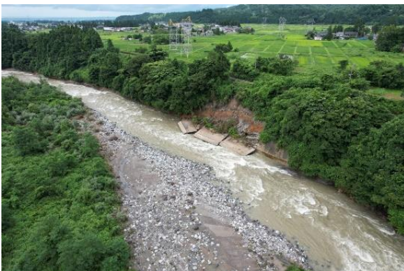
立山町岩嶺寺 白岩川 堤防復旧工事
