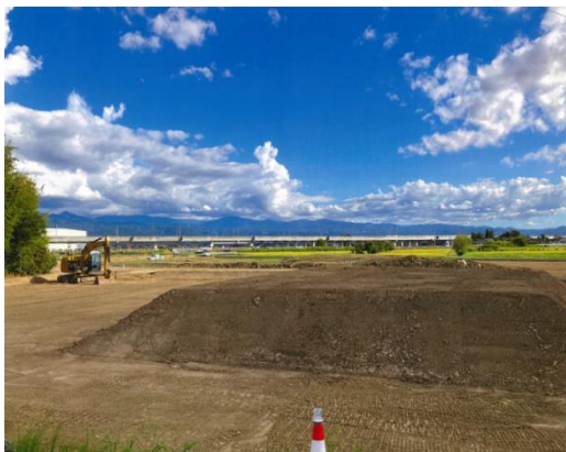
ほ場整備 上条中部地区工事
